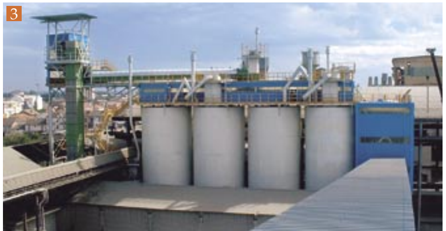
Al centro i silos di stoccaggio delle materie prime, circondati dal sistema di trasporto e di distribuzione.
