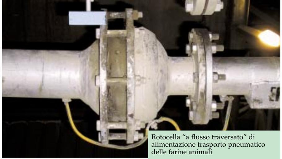
Rotocella "a flusso traversato" di alimentazione trasporto pneumatico delle farine animali
