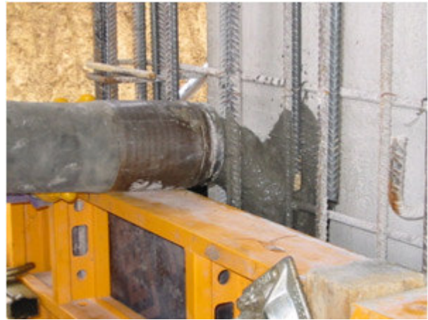
Fig. 4. Pouring in thin sections
